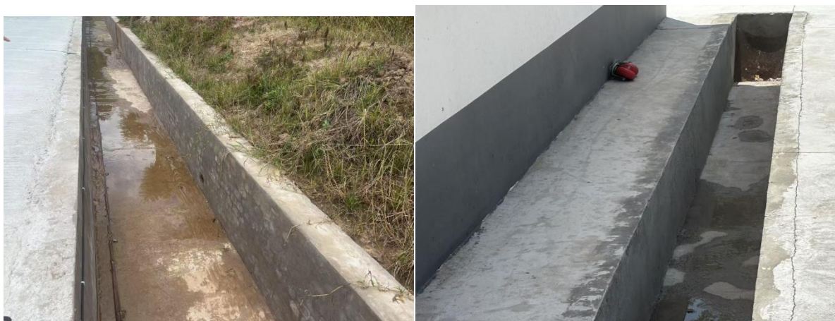
图 2.6-2 已实施水保措施照片（排水沟）
